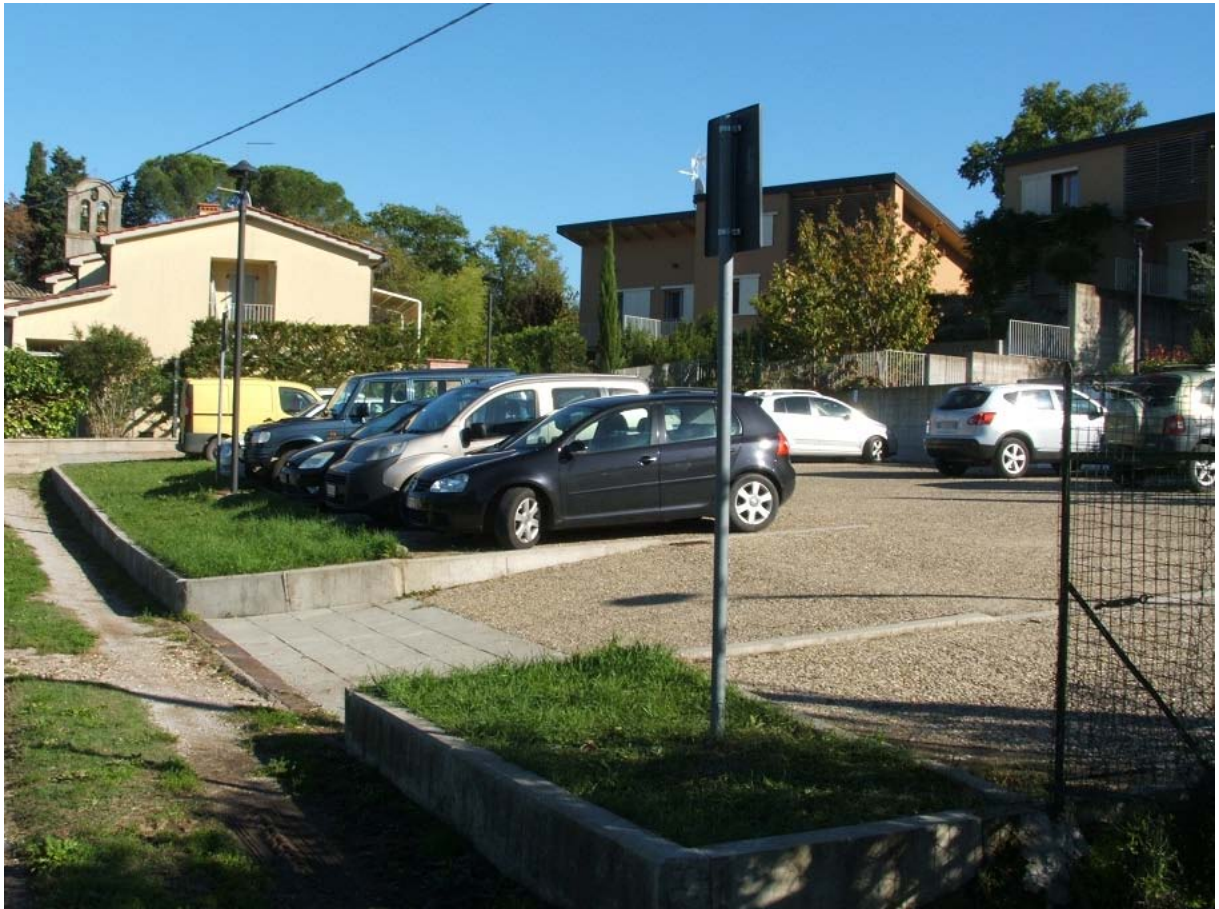
Area Attesa Popolazione AP06: estensione dell'area nella zona residenziale di nuova realizzazione
