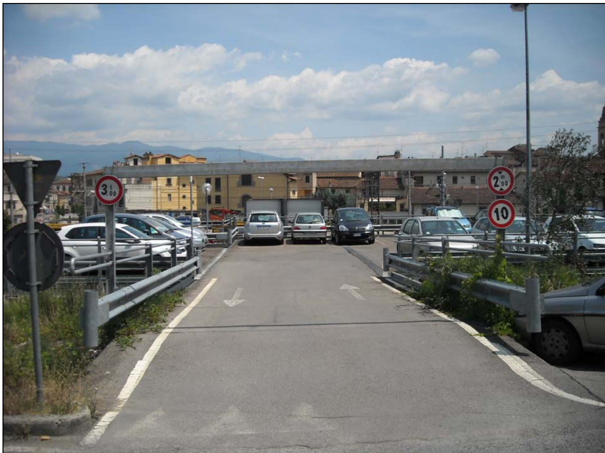
Area ricovero popolazione RP01: ingresso al piano superiore del Fastpark
