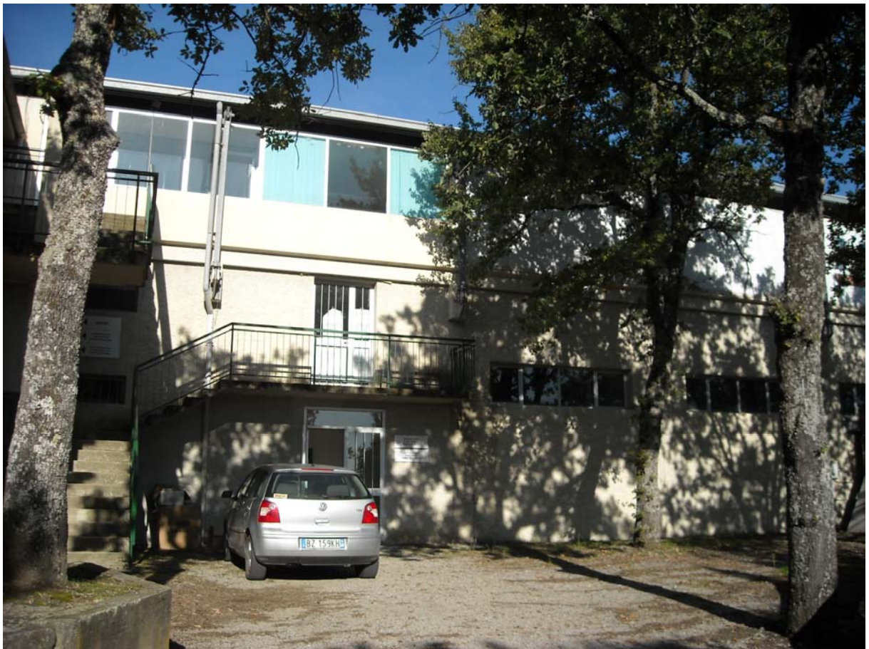
Area Ammassamento Soccorritori 01S Area Cocioioni – sede C.O.M.
