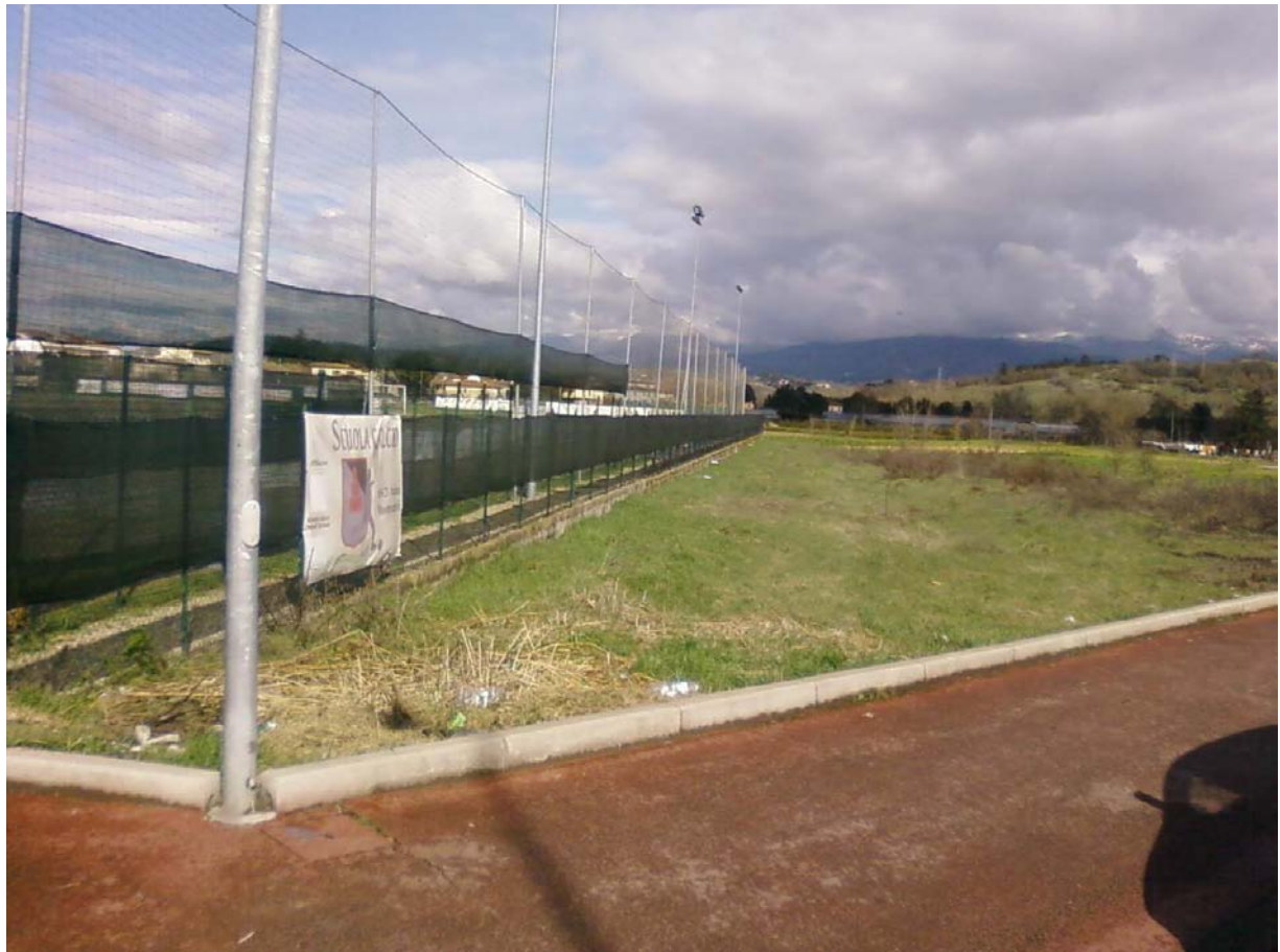
Area ricovero popolazione RP07: Vista laterale del campo sportivo, lato via Ruini
