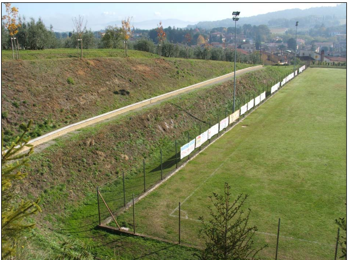
Area ricovero popolazione RP02: panoramica del lato verso Est
