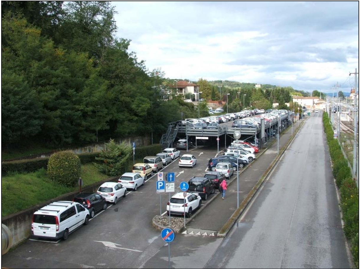
Area ricovero popolazione RP01: veduta panoramica dell'area
