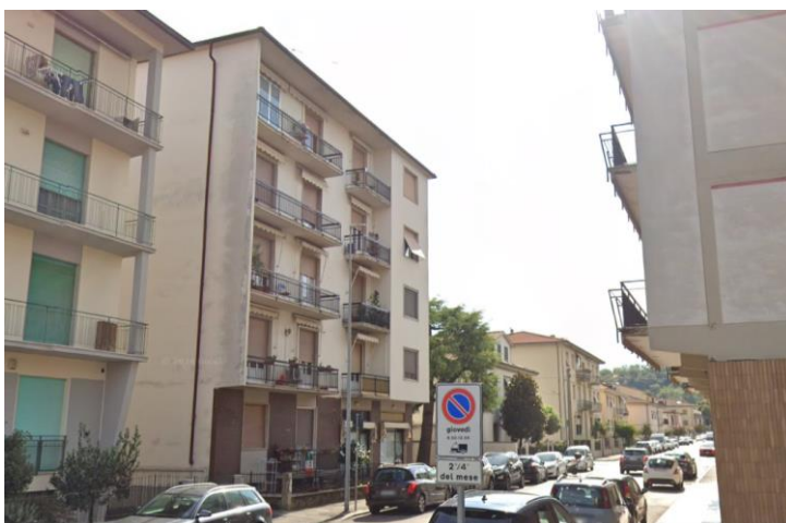
Figura 28 - Fabbricato in Via XXIV Maggio 50/1
