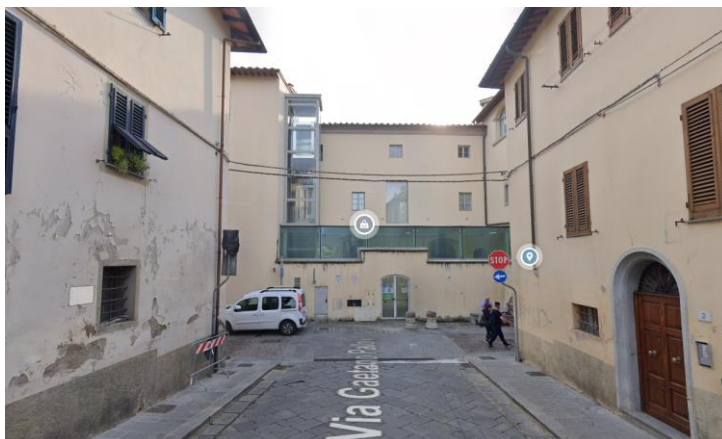
Figura 33 - Vista del bene
