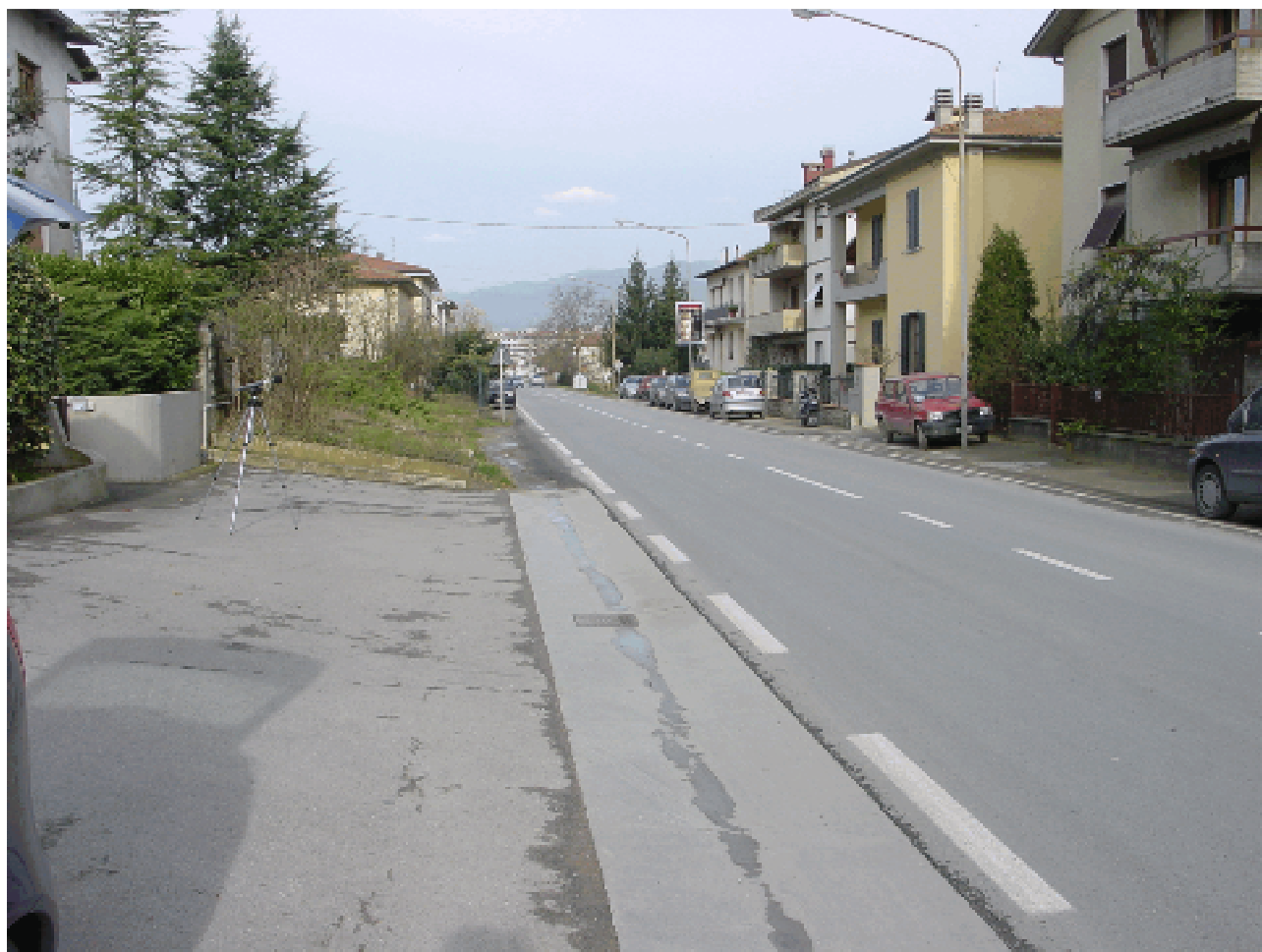
Punto di misura n.5 - Montevarchi S.S. n.408 via Chiantigiana (P5)
